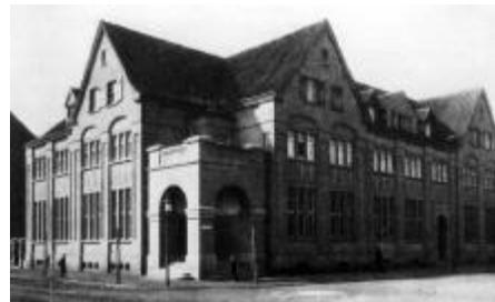
Konsumgebäude Bildquelle: Archiv der Thyssen Krupp AG Duisburg
