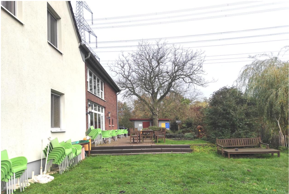
Abbildung 5: Blick entlang des südöstlichen Randbereiches des Plangebietes auf einen Walnussbaum und dahinterliegendes Nebengebäude; links: Hauptgebäude; rechts: Gartenbereiche außerhalb des Plangebietes (eigene Aufnahme 15.11.2024)
