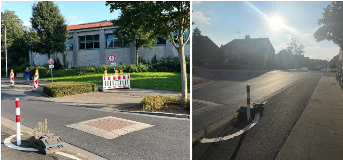
Abbildung 29: Baustellenbeschilderung auf dem Gehweg und Kreuzungsbereich Rosenstraße/Averbruchstraße
