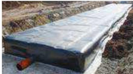
Regenwasserspeicher mit Folienummantelung
