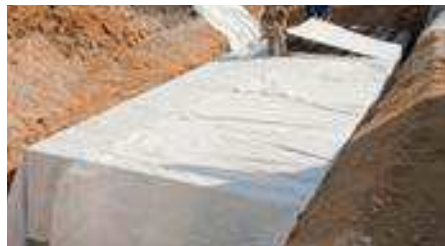
RAUSIKKO Box-Rigole mit Filtervlies RAUMAT
