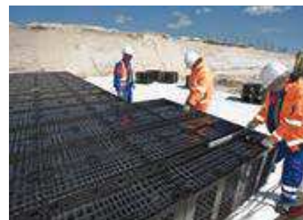
Einbau der RAUSIKKO Boxen
