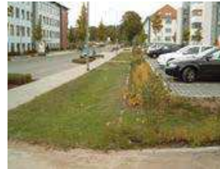
Versickerungsmulde einer Mulden-Rigole nach Fertigstellung
