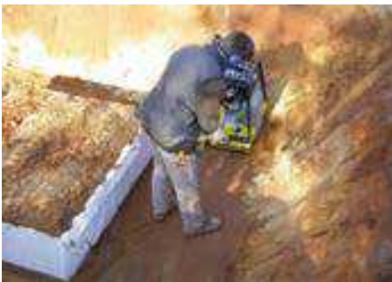
Verdichten des Arbeitsraumes
