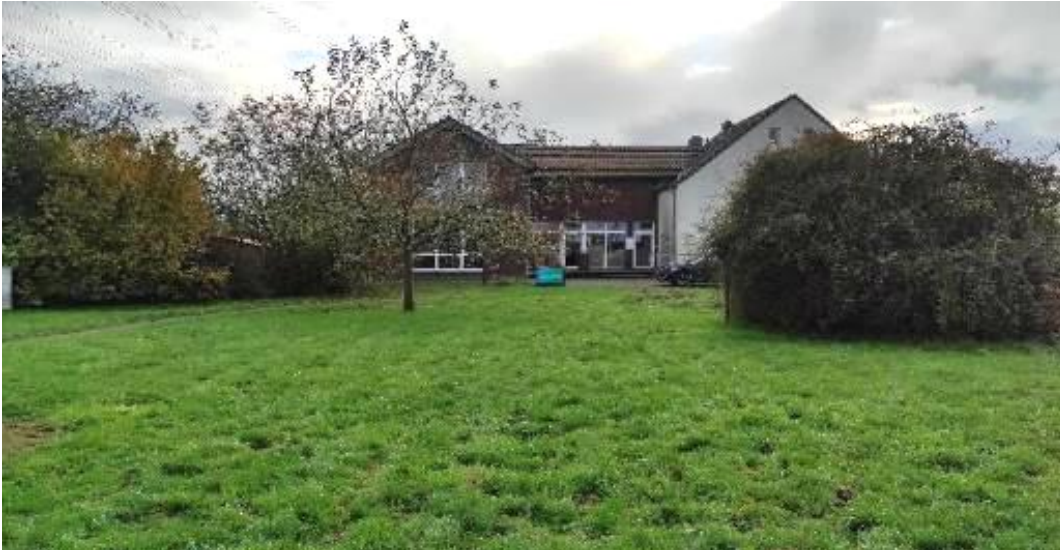
Abbildung 10: Blick aus nordwestlicher Richtung auf den Emscherhof (eigene Aufnahme, 15.11.2024)
