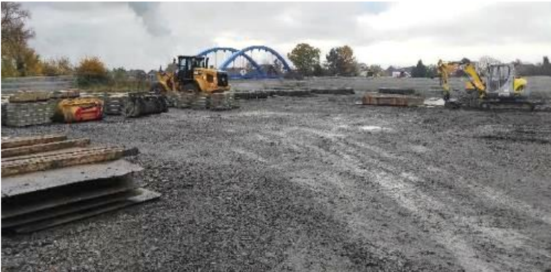
Abbildung 7: Blick über das südliche Plangebiet mit derzeitigen Baustelleneinrichtungsflächen auf die Emscherbrücke (eigene Aufnahme, 15.11.2024)
